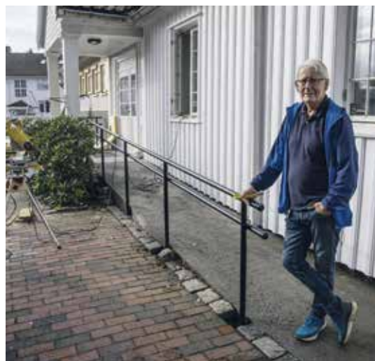
Rydder vei: Den nye rullestolrampen i betong bærer Roald sin signatur. – Men jeg er altså ikke alene om dette, i dugnadsgjengen jobber vi i team for å løse oppgavene, presiserer han.
